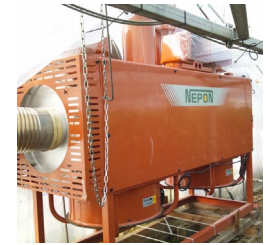
重油ボイラー
