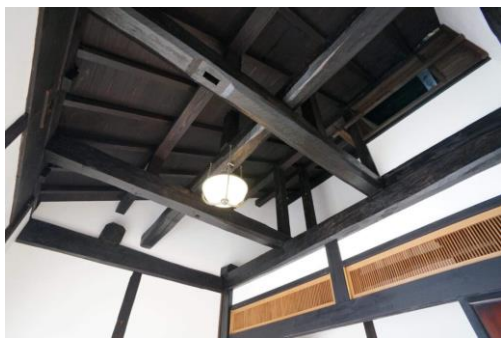
解体した古民家を移築し古材を再利用
