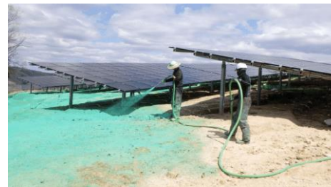
浸食防止材緑化用のオリジナル配合溶液を混合、攪拌した後、対象地盤へ散布浸透
