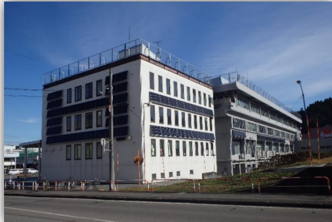
市役所庁舎の太陽光発電設備
