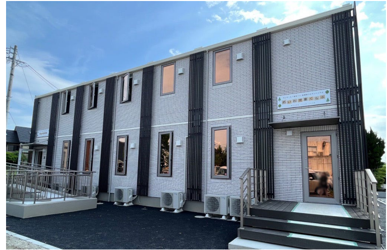
〔写真:愛知県常滑市〕
