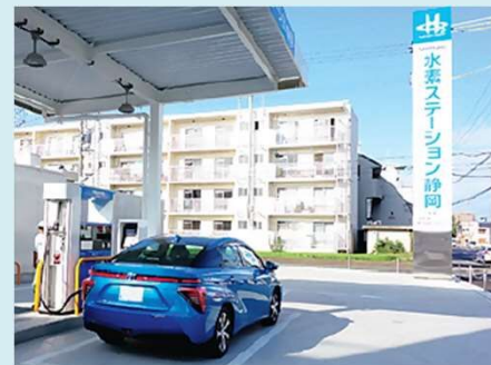
水素ステーションと燃料電池自動車
