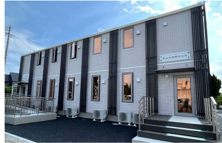
〔写真：愛知県常滑市〕
