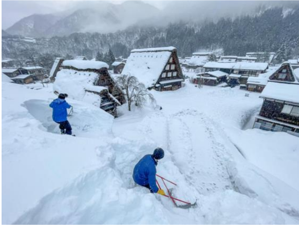
屋根の雪下ろし
