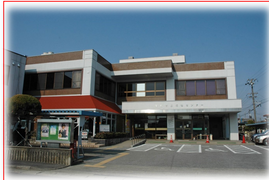
老人福祉センター・中央コミュニティセンター (S50築)
