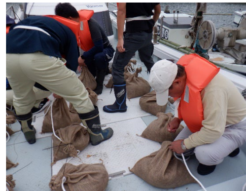
麻袋に腐葉土混合砂、種子、砕石を投入し、モニタリング
