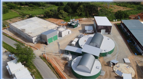
ながめやまバイオガス発電所
