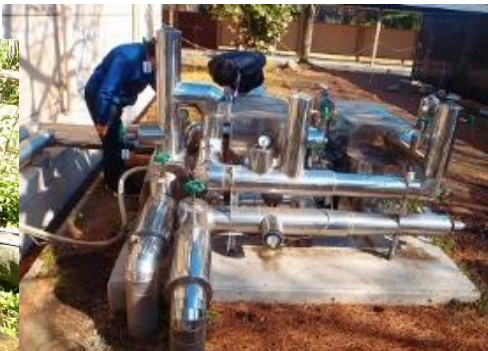
市有施設に導入した温泉熱利用設備
