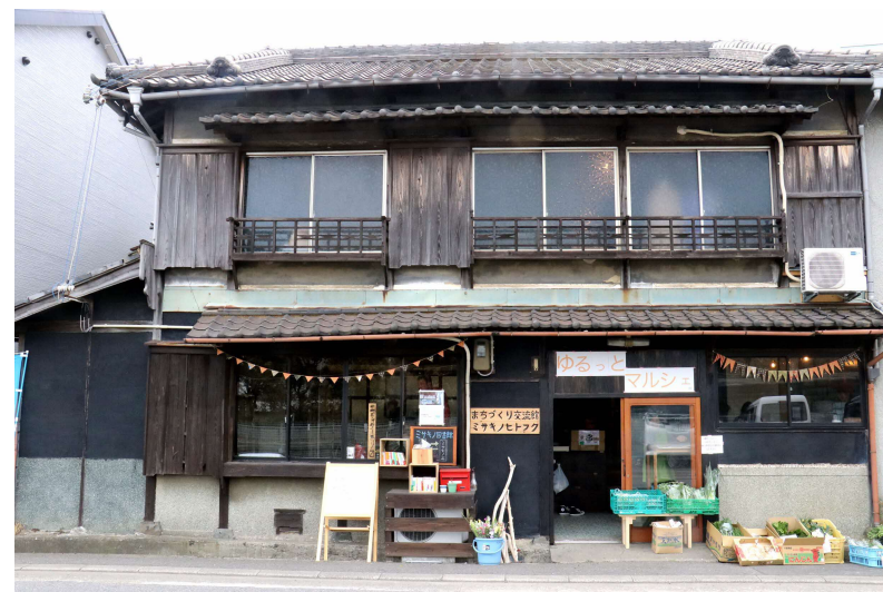
南海電鉄多奈川駅前 木造2階建て 元旅館
