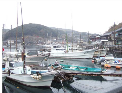
大島港 (浮棧橋を整備し利便性の向上を図る)
