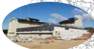
三木浄化センター(仮称)水処理施設
