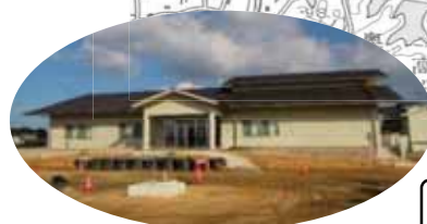
三木浄化センター(仮称)管理棟
