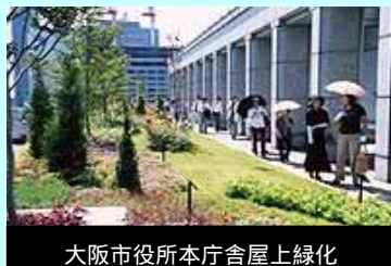
大阪市役所本庁舎屋上緑化
