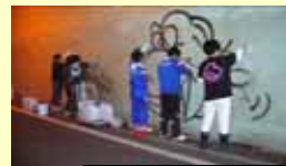
トンネル内の落書き消し
