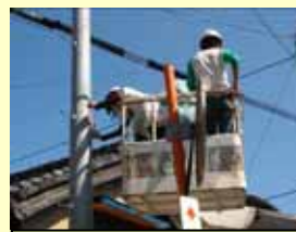
津波高表示テープの設置
