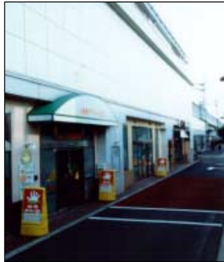
小田急 喜多見駅(高架下)
