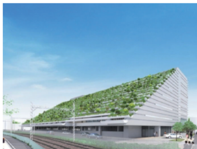
市川市新第1庁舎（建設中）
