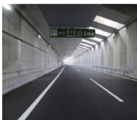
東京外かく環状道路
