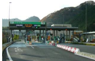
八王子西インターチェンジ
