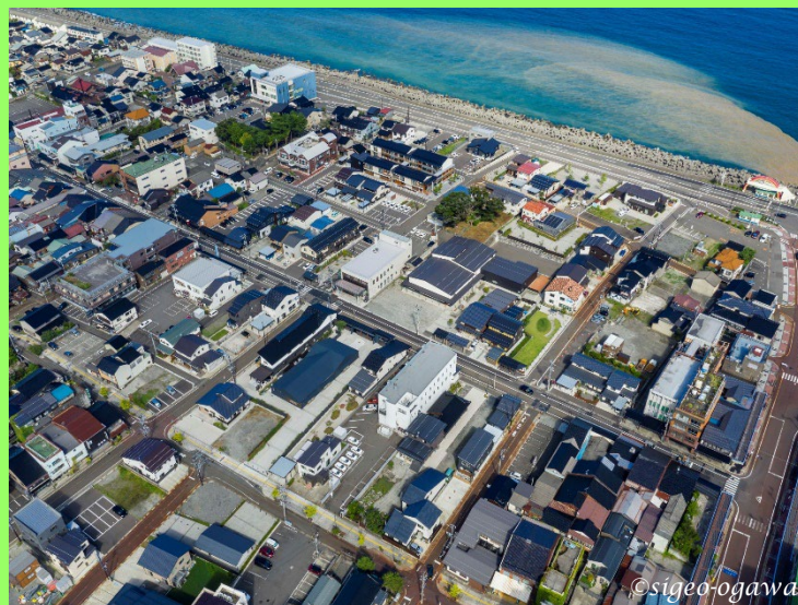
H28. 12糸魚川市駅北大火から復旧した 都市機能誘導区域内にある糸魚川市駅北地区の上空写真
