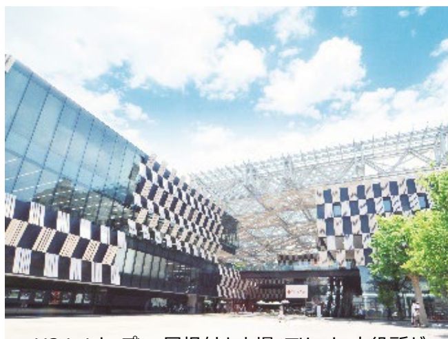
H24.4オープン 屋根付き広場・アリーナ・市役所が 一体となった全国初の複合施設「アオーレ長岡」
