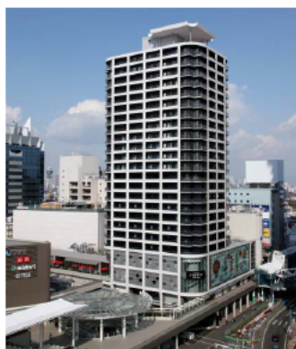
③あべの nini (H24 竣工)
