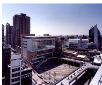
②キューポ・ラほか (H18 竣工)
