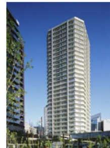
③ソルクレスト川口 ザ・タワー (H19 竣工)
