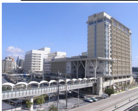
①カフーナ旭橋（南工区）（H24 竣工）
