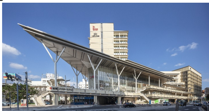
②カフーナ旭橋（北工区）（H30 竣工）
