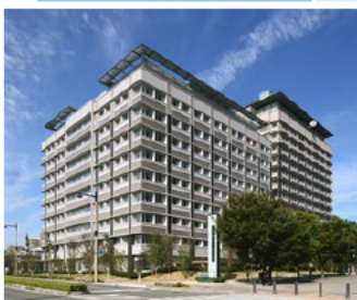
①高松サンポート合同庁舎 (北館 H18、南館 H29 竣工)
