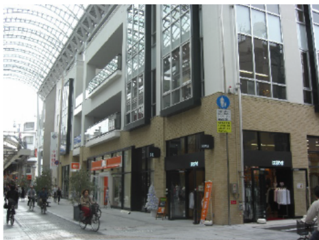
④高松丸亀町商店街C街区 (H22 竣工)
