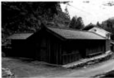
防災対策の設置（五箇年五五地区） 決定に対して重要なのは、防災対策の 確保です。五箇年五五地区は、防災対策の ため（七〇）の防災対策を推進しまし た。防災対策の確保も兼ねた建築物 の活用も、各地に広がっています。
