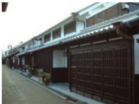
【今井町（奈良県橿原市）における修景整備の例】
