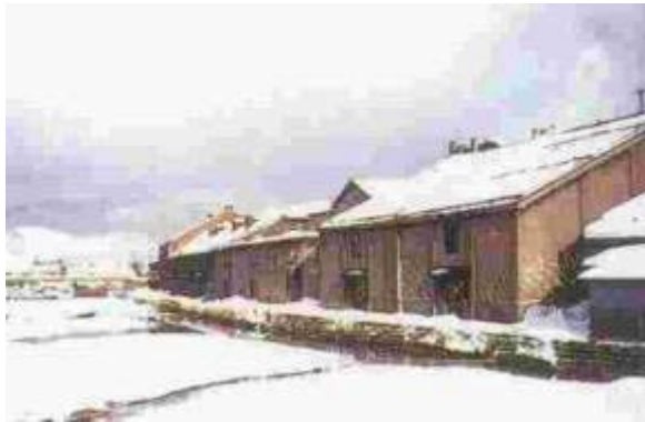
整備前の小樽運河
