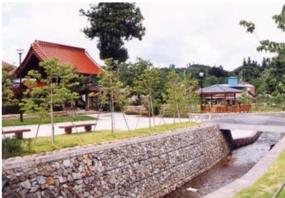
水路を活用した小公園の整備（山口県楠町吉部市地区）
