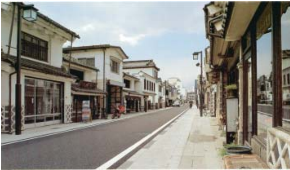
道路の美装化と併せて電柱類の地中化を実施（長野県松本市中町地区）
