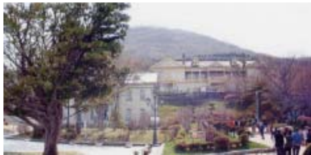
手前の建物：旧北海道庁函館支庁庁舎
