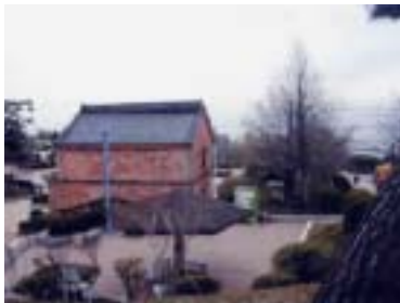
旧开拓使函館支庁 レンガ造倉庫
