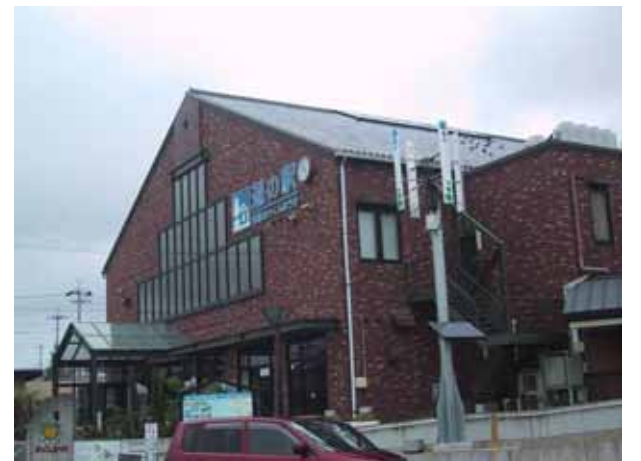
道の駅田原めっくんはうす 小型風力発電 H16.7 設置 民間団体寄付
