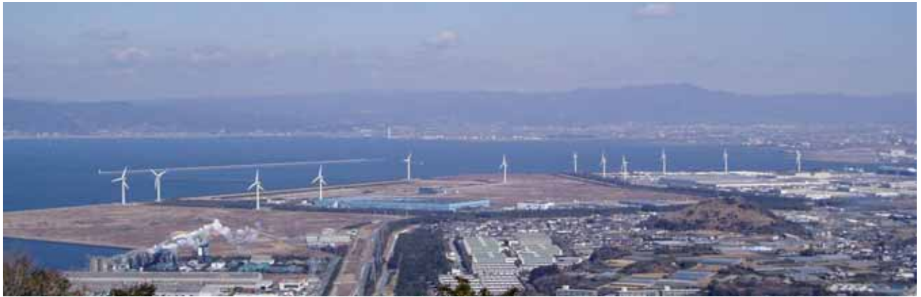
田原臨海ウインドファーム 合計出力 23,980kW（H16.3 運転開始 1,980kW×1 基、H17.3 運転開始 2,000kW×11 基）
