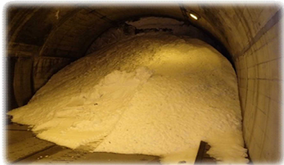
【写真】大滝地区トンネル
