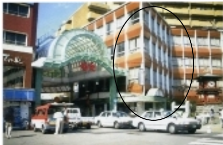
観光案内所の入居するビルの改修
