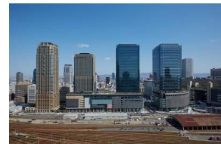
グランフロント大阪 （大阪駅周辺・中之島・御堂筋周辺地域）
