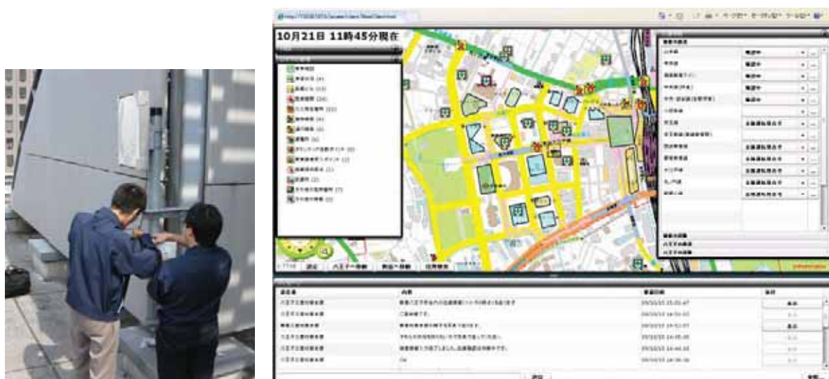
図3 工学院大学新宿校舎屋上(30階)に設置しているFWAのアンテナ（左、学内の防災用LANからPoEにより電力供給）と、FWAを利用して様々な災害情報等を共有できる災害情報共有システムの画面例（右）
